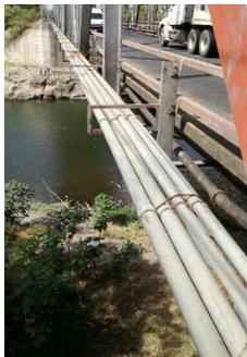
Fotografía 8. Tuberías de servicios públicos que utilizan el puente como soporte.
