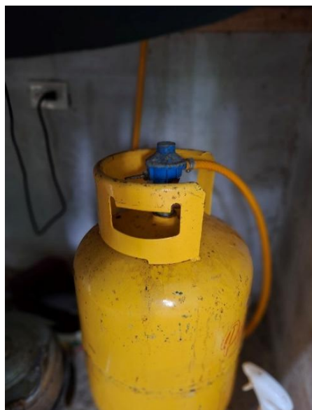
Tanques de gas ubicados en el interior de la vivienda
