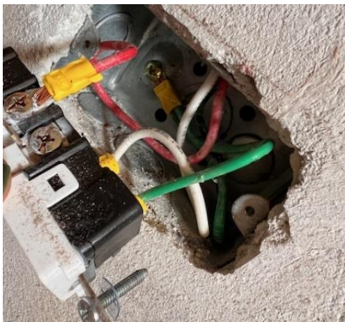
Instalación correcta de receptáculo
