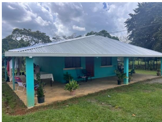
Ampliación de Aleros
