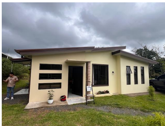
Vivienda con acometida subterránea
