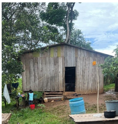
Vivienda anterior no demolida
