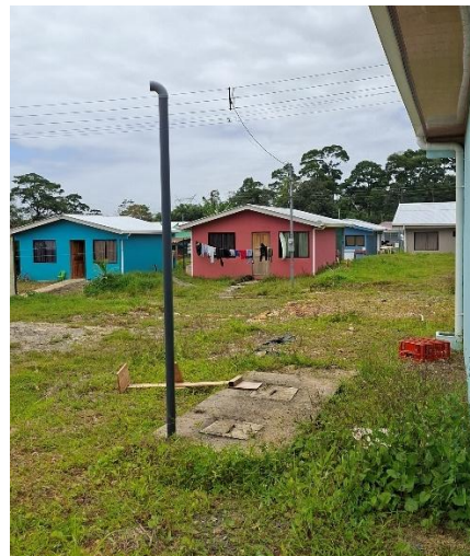
Ventilación de sistema sanitario
