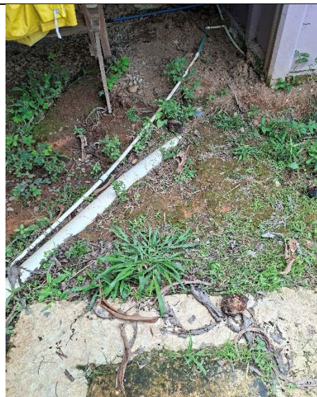
Tubería expuesta
