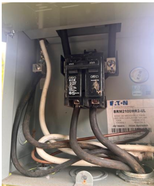
Vivienda con acometida subterránea
