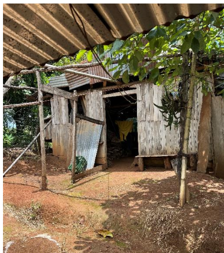
Vivienda anterior no demolida
