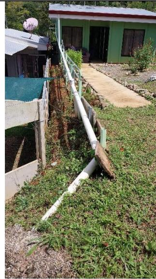
Vivienda que tiene largo sistema de tubería. Si bien es muy positivo el no acumular agua en el terreno (dado el desnivel) el sistema es muy vulnerable a un golpe. Es buena práctica montar la tubería sobre una estructura fija que permita reducir el riesgo de impactos.
