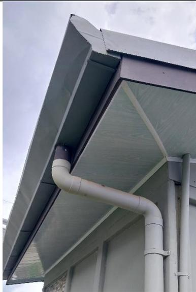
Sección de canoas, bajantes y aleros bien colocados. Se observa la utilización de canoa HG y bajante PVC
