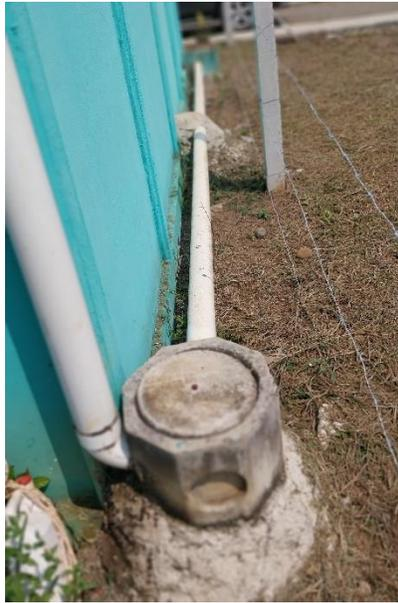
Sistema de evacuación pluvial y conexiones reforzadas con concreto. Es recomendable que también la tubería pudiera quedar cubierta con tierra, para evitar que se dañe con impactos
