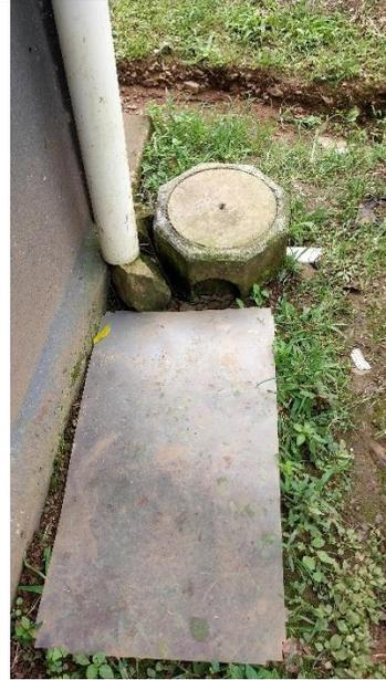
Bajante que no está conectado al registro y las aguas corren por el terreno. Para evitar erosión el agua cae sobre pieza de cerámica.
