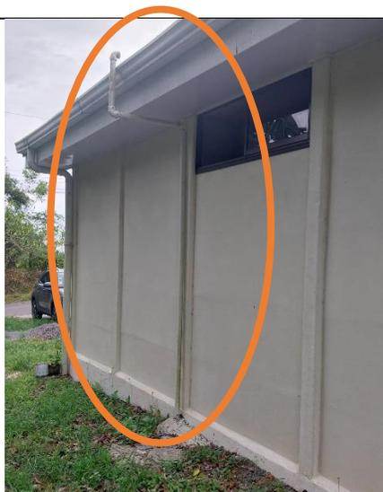
Buena práctica de ventilación de TS apoyada en pared y con salida a nivel superior
