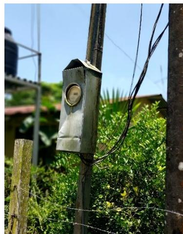
Se encontraron varias viviendas donde se mantuvo la conexión eléctrica de la vivienda anterior y no se realizó el cambio a la instalación nueva. Esto ocasiona que existan viviendas con buenas condiciones a nivel interno, pero un riesgo externo al seguir con una conexión de baja calidad.
