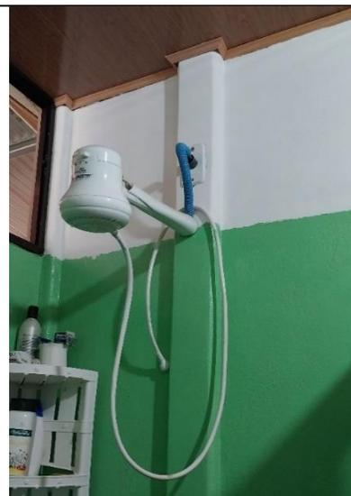
Instalación de termoducha. Se observaron buenas prácticas como tuberías flexibles o cajas preparadas para una futura conexión
