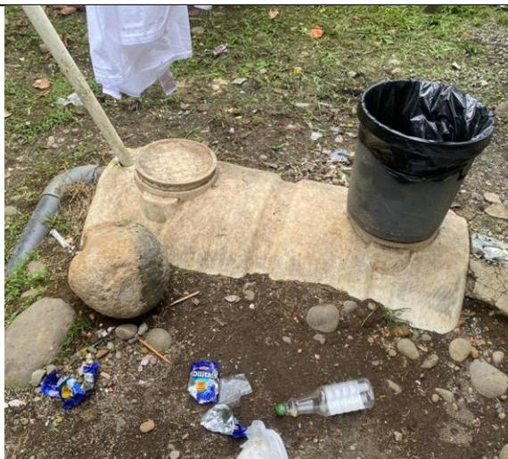
Tanque séptico de plástico parcialmente enterrado. No cuenta con registro previo. La tubería de ventilación no cuenta con apoyo.
