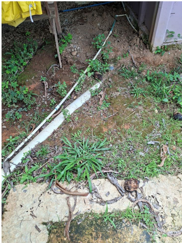
Tubería expuesta
