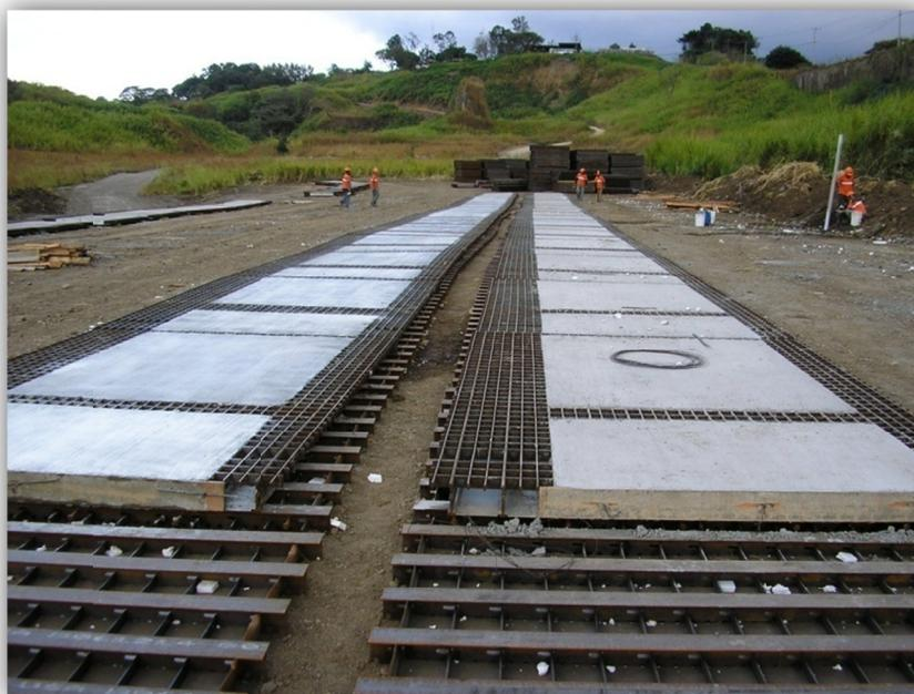
Figura 46. Plantel de prefabricación de rejillas
