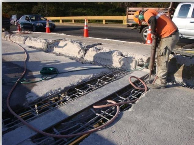
*Figura 50. Demolición de la losa*
