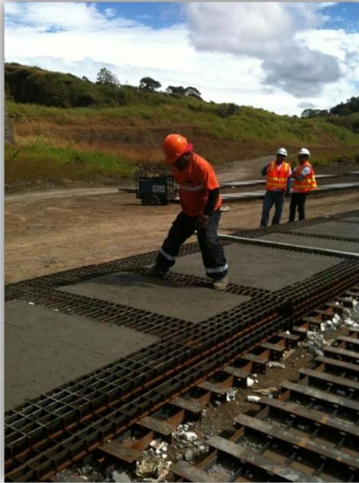
*Figura 47. Plantel de prefabricación de rejillas*
