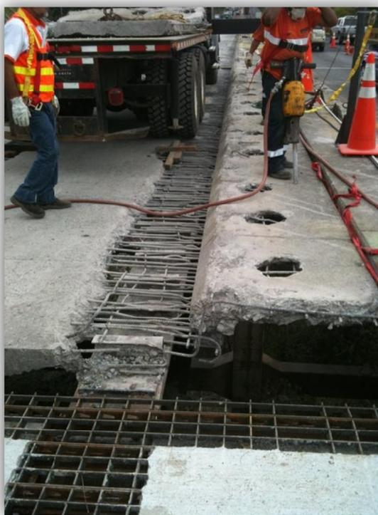
*Figura 51. Demolición de la losa y colocación de la rejilla*
