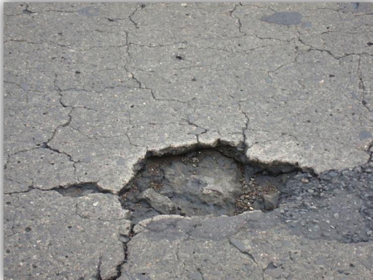
*Figura 16. Ejemplo de orificio en la losa*
