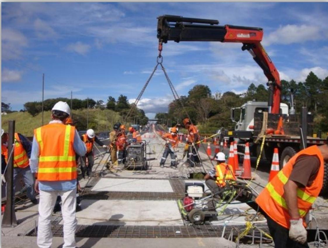
*Figura 48. Colocación de rejillas en el puente*
