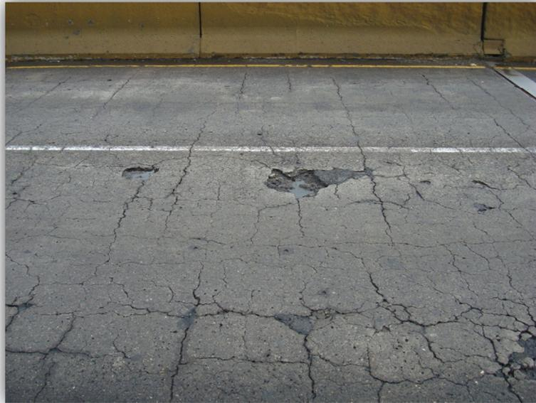
*Figura 15. Orificios en la losa*
