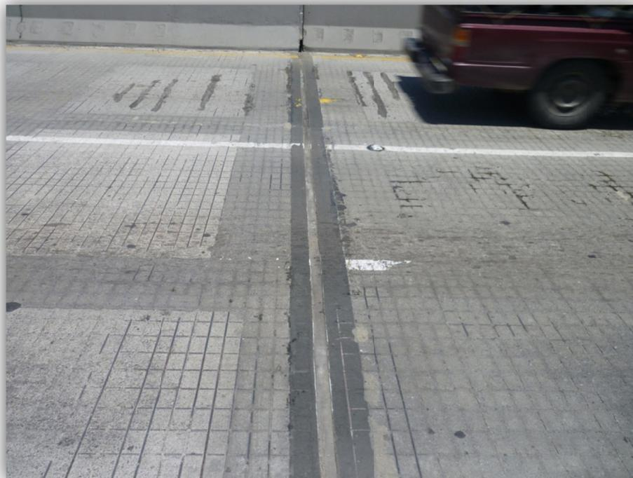
*Figura 40. Junta de dilatación en puente*
