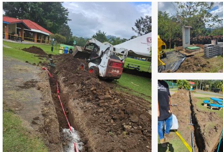
Mejoras eléctricas en las instalaciones
