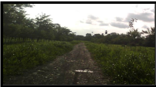
F6. La ruta no cuenta con drenajes, en el recorrido se observa surcos y baches, también se observa sobre tamaño en los agregados no apto para caminos
