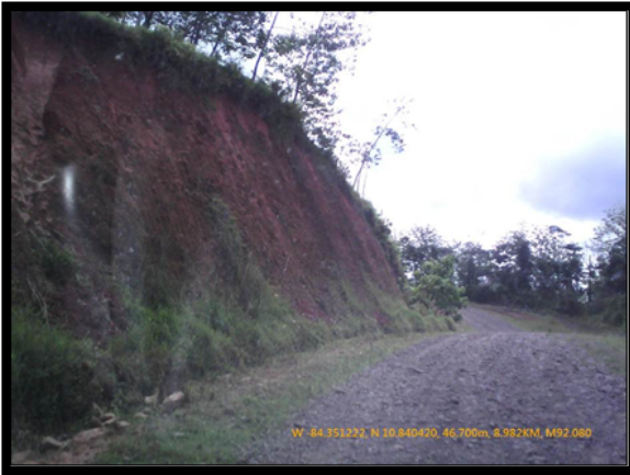
F22. Talud de aproximadamente 6m de altura con pendiente casi vertical
