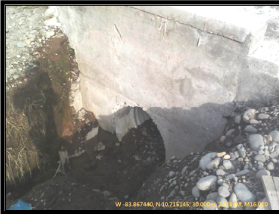
F3. Alcantarilla de PVC corrugada con obstrucción, por la migración de finos de la capa base
