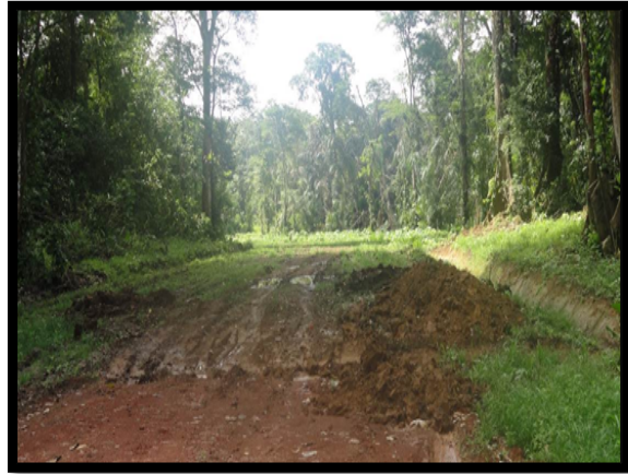
F12. Caminos de tierra con acumulación de agua, hace intransitable el camino, se observa afectación al bosque
