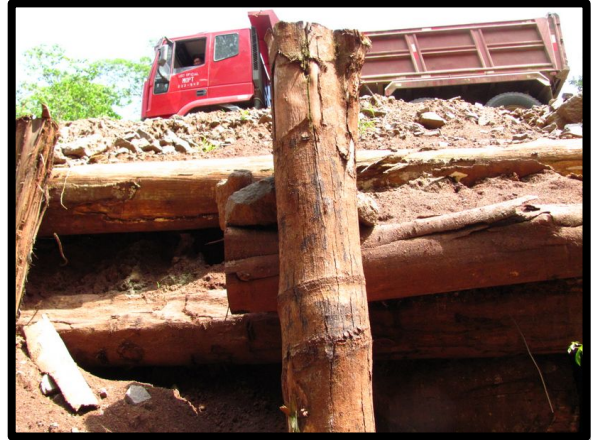
F49. Puente en uso por maquinaria pesada.
