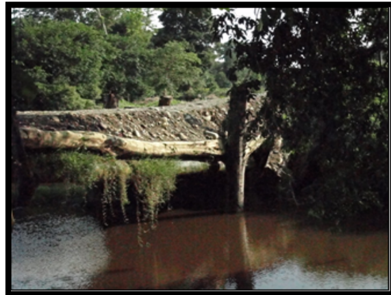
F5. Puente con estructura de troncos de madera
