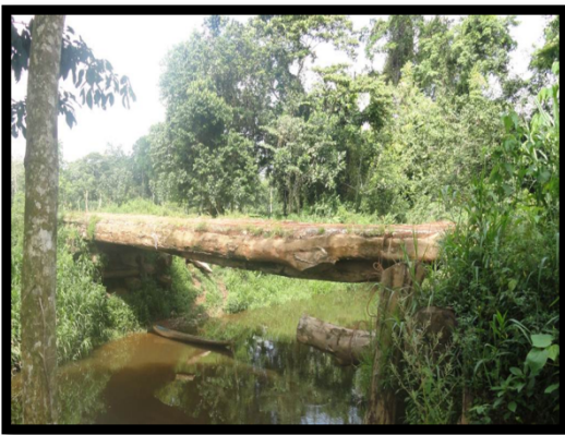
F13. Se observa diferentes puentes conformados por troncos de madera
