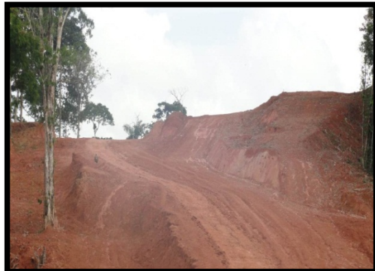
F14. Camino de tierra sin drenajes, al no contar con planos se hicieron cortes y rellenos en forma desordenada
