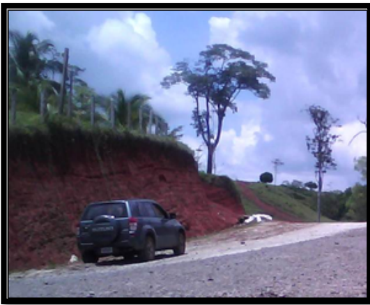
F27. En este sector presentan taludes de grandes dimensiones con pendientes elevados y sin protecciones.
