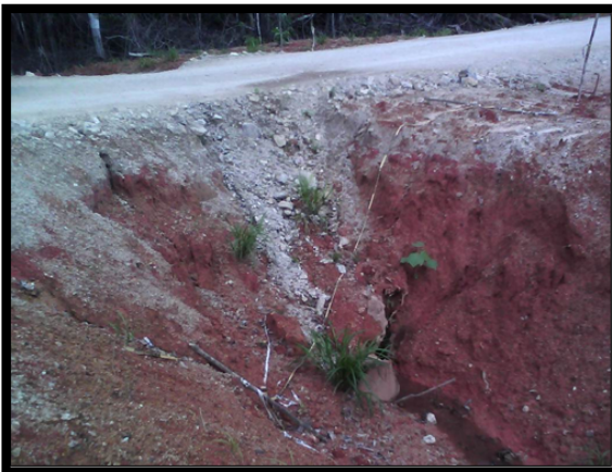
F32. Utilizan troncos de maderas para permitir paso de agua como alcantarillas
