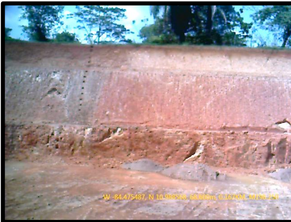
F50. Corte de talud con altura aproximada de 6 m.
