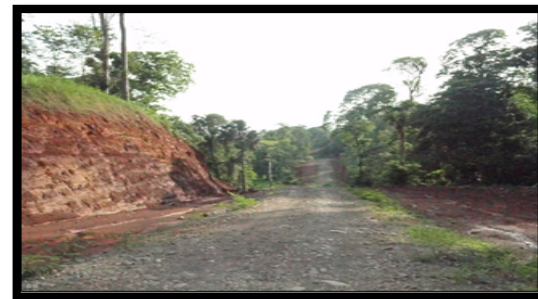
F6. La ruta no cuenta con drenajes, en el recorrido se observa surcos y baches, también se observa sobre tamaño en los agregados no apto para caminos
