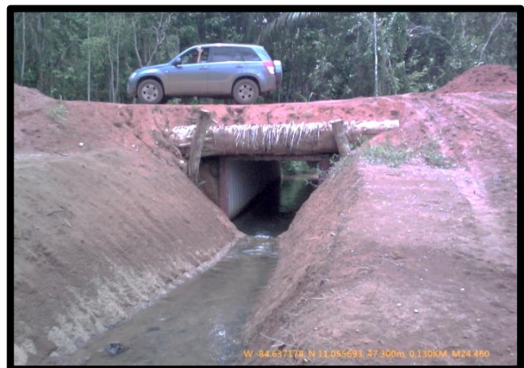
F42. Tramo con espacio para el tránsito de un vehículo.
