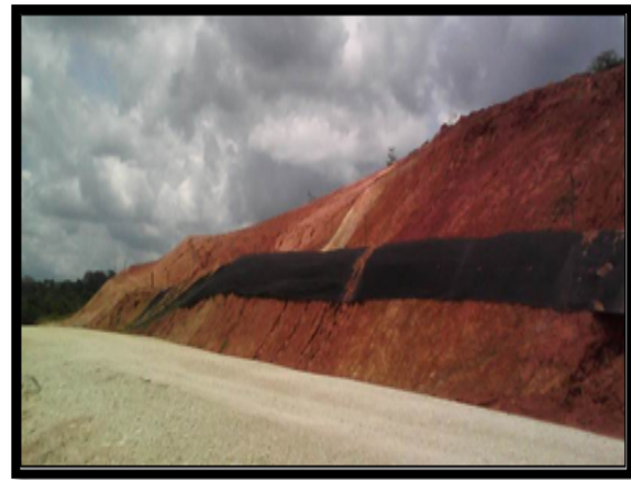
F27. En este sector presentan taludes de grandes dimensiones con pendientes elevados y sin protecciones.
