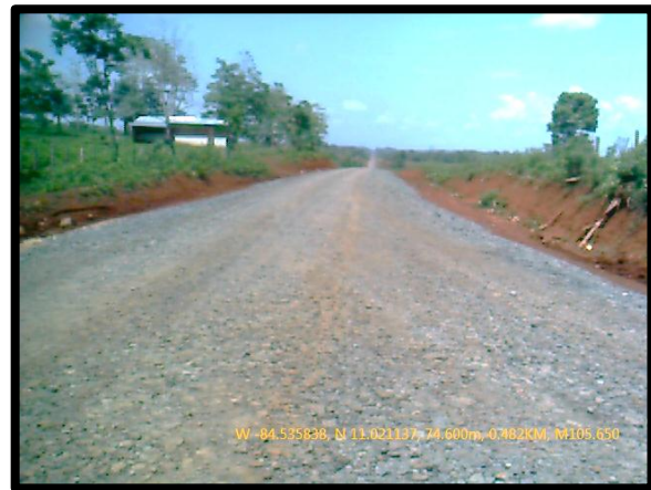
F45. Vista de tramo en lastre.
