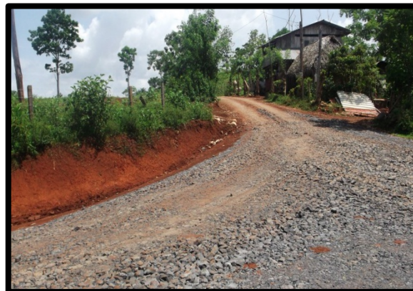
F38. Acceso en tierra desde Ruta 760 El Parque
