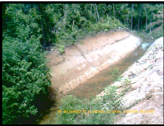
F52. Cuneta en tierra para evacuación pluvial.
