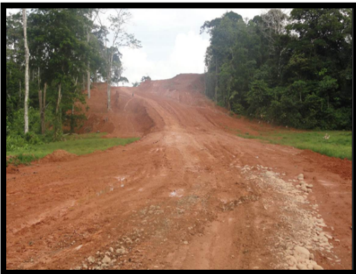
F14. Camino de tierra sin drenajes, al no contar con planos se hicieron cortes y rellenos en forma desordenada
