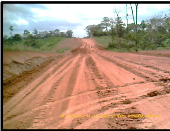
F44. Vista de tramo en tierra.
