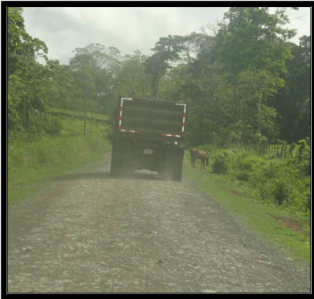
F9. En general la ruta se encuentra en buenas condiciones
