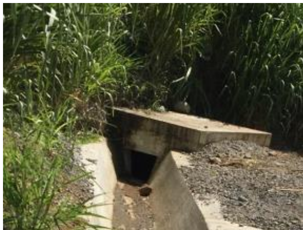
Fotografía 7. Caja de registro en la salida de la alcantarilla en estacionamiento 21+700.
