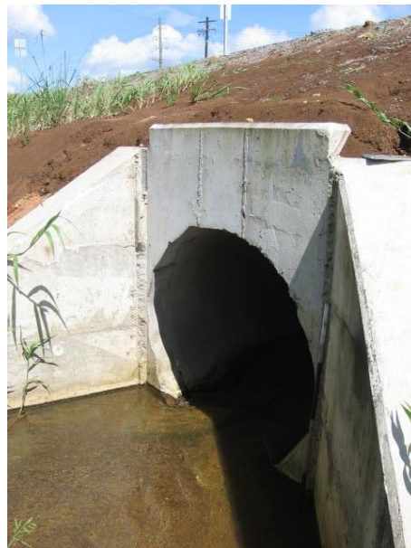
Fotografía 4. Cabezal de entrada de la alcantarilla en el estacionamiento 21+500.
