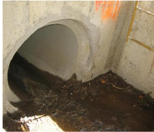
Fotografía 15. Tubería de salida de la caja de registro, sector Sur.
