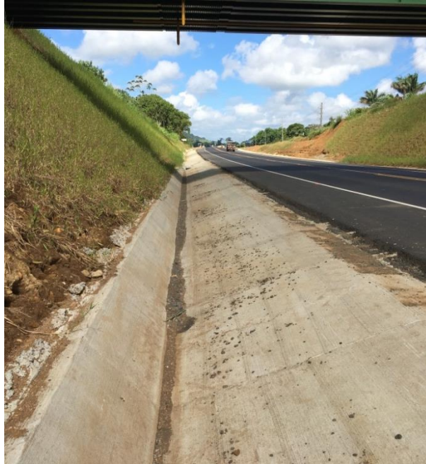
Fotografía 19. Cuneta típica en el tramo en consideración.
