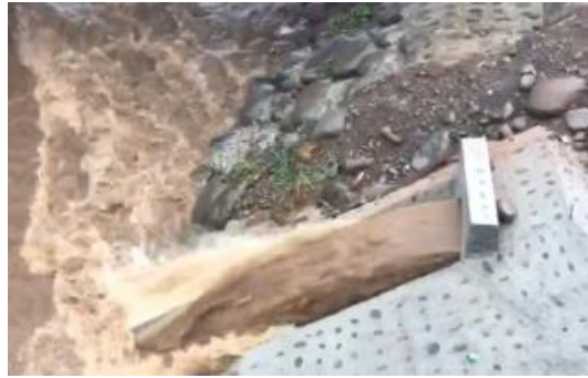
Fotografía 21. Desfogue pluvial en operación. (Viquez y Monge, 2017)
