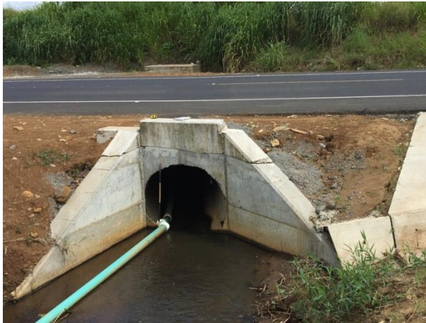
Fotografía 5. Alcantarilla en el estacionamiento 21+700.
