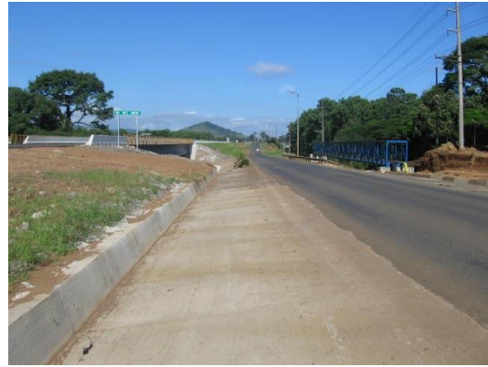
Fotografía 24. Cuneta del sector Norte, punto de drenaje 4.
