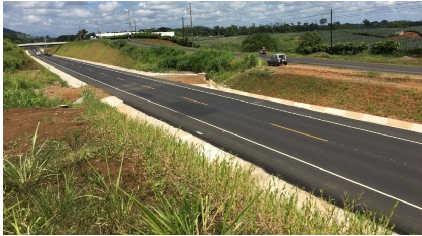
Fotografía 2. Tramos de carretera entre los estacionamiento 21+700 y 21+870 m.
