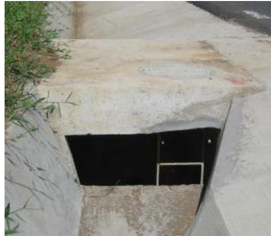
Fotografía 10. Tragante en el sector Sur de la vía, Estacionamiento 21+900.
