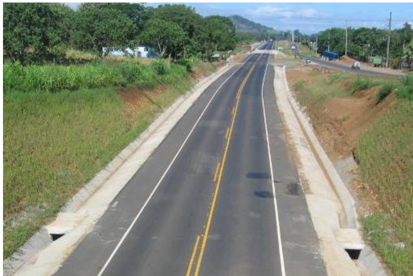
Fotografía 3. Sector comprendido entre los estacionamientos 21+900 y 22+200 m.
