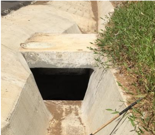
Fotografía 9. Tragante en el sector Norte de la vía, estacionamiento 21+900.
