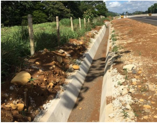
Fotografía 23. Cuneta del sector Sur, punto de drenaje 4.
