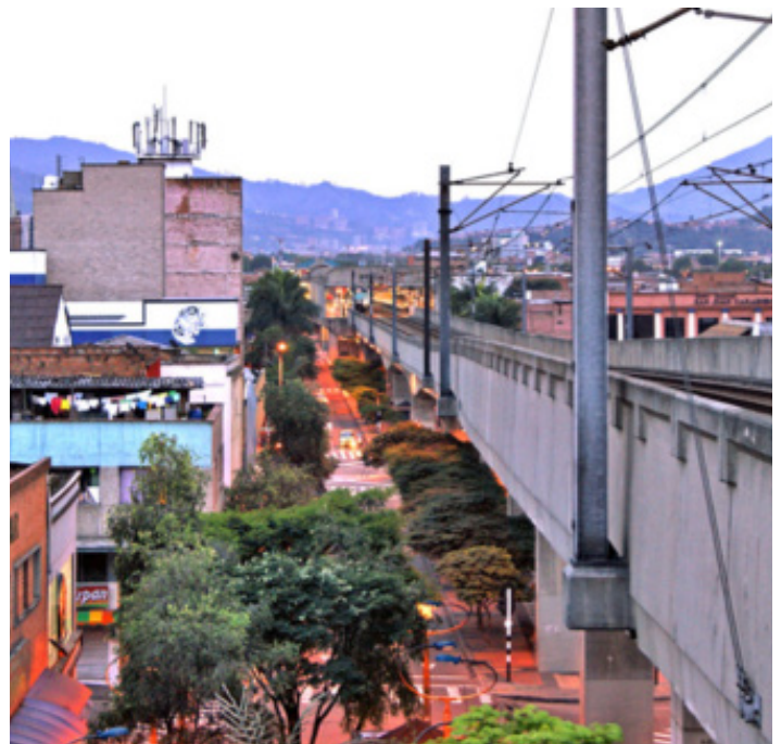
Figura 4: Estación del Metro de Medellín la ciudad vrs. estructura elevada.
