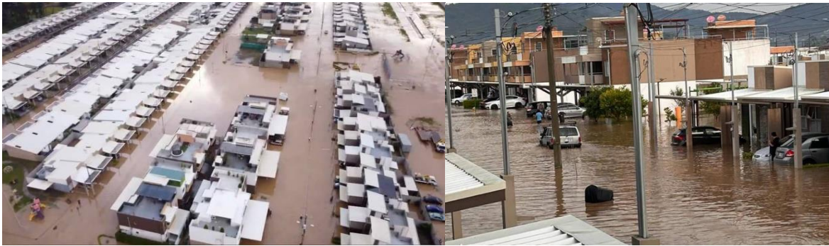
Figura .4.10. Lluvias extremas anegaron 450 casas en El Guarco, dañaron tuberías, postes y socavaron puente
