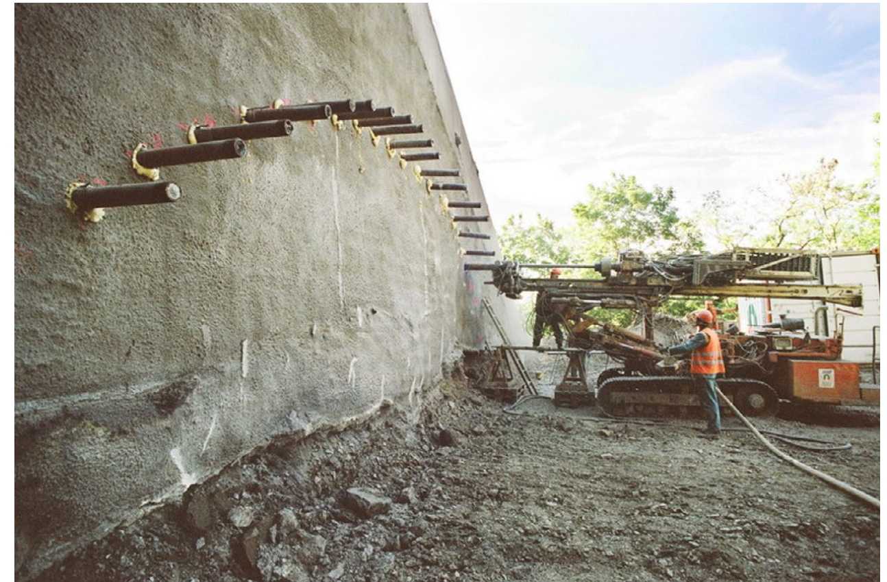
Fotografía 25. Paraguas de tubos en el portal del túnel.
