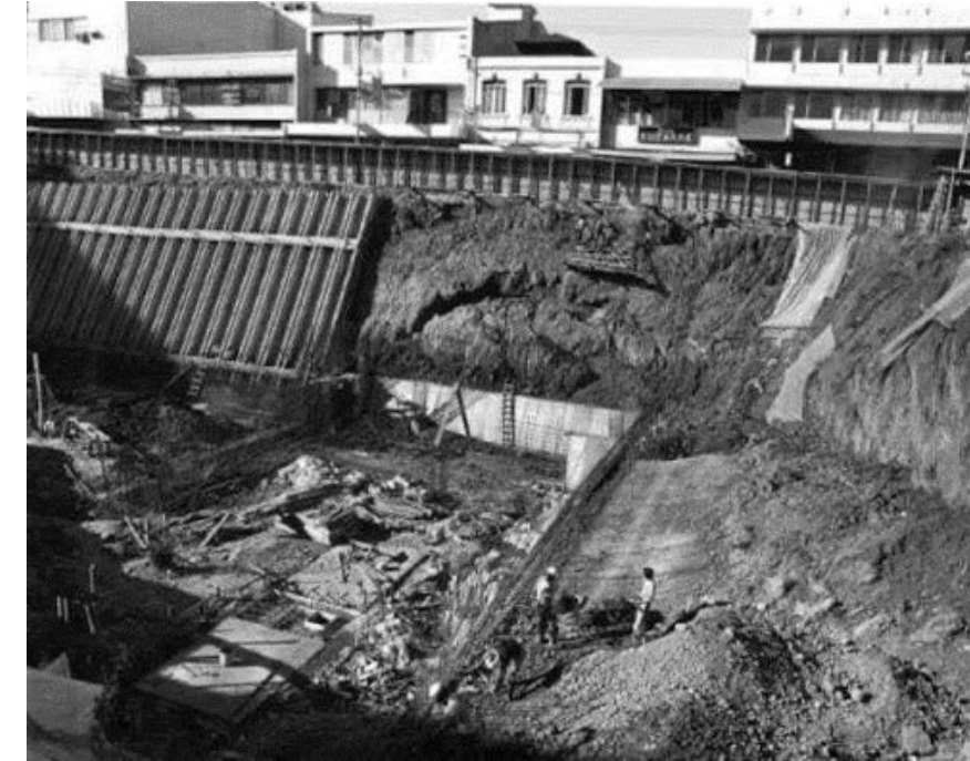
Fotografía 17. Excavación de la Plaza de la Cultura. Descargado de: https://maritzacartin.files.wordpress.com/2022/03/img_0502.jpg
