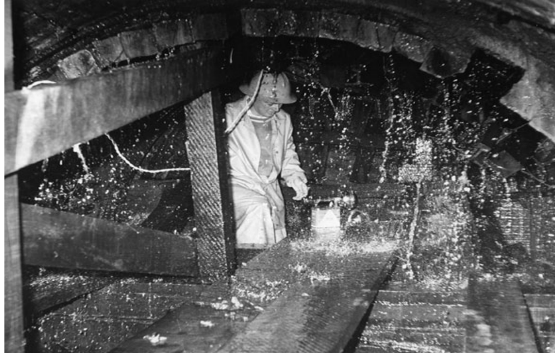
Fotografía 5. Túnel de Tapantí. Condiciones de trabajo y tipo de soporte.
