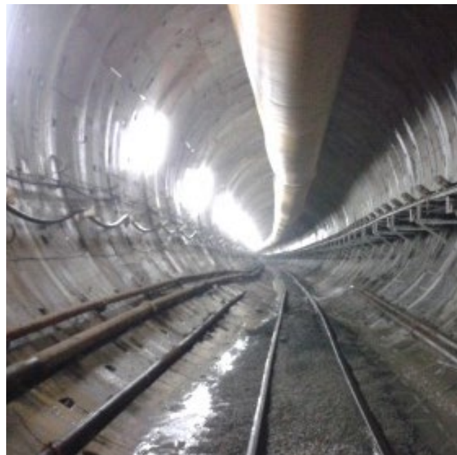
Fotografía 9. Tramo de túnel del PH Torito ya revestido.
