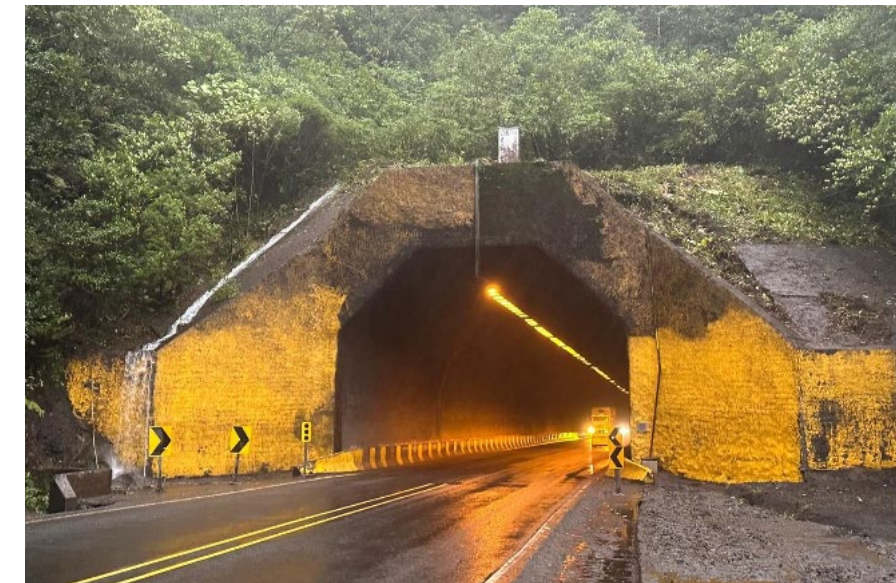
Fotografía 4. Túnel bajo el cerro Zurquí, primer túnel carretero del país (1984) Arriba: durante el proceso constructivo. Abajo: operación actual.
