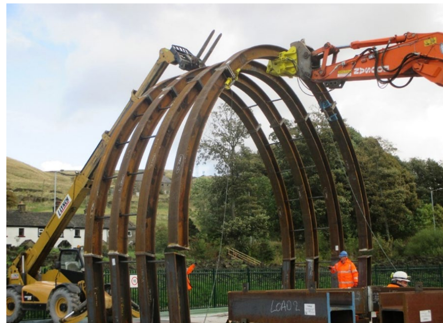
Fotografía 23. Armado de arcos de acero (pruebas en exterior).
