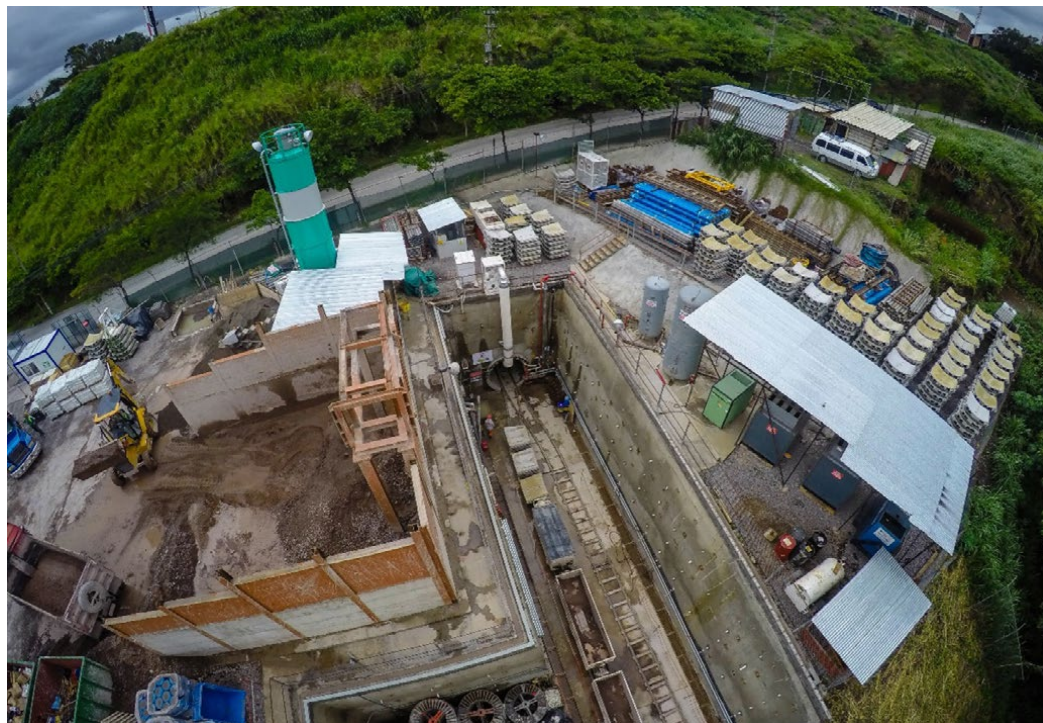
Fotografía 13. Sitio de obras durante el proceso constructivo del túnel de trasvase.
