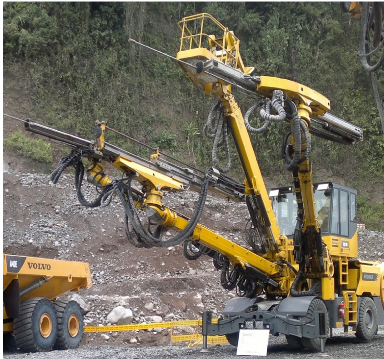
Fotografía 29. Jumbo de perforación utilizado en el proyecto hidroeléctrico Reventazón
