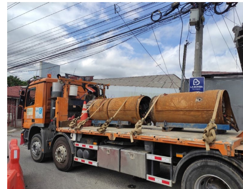
Fotografía 15. Micro tuneladora tipo “slurry” utilizada en micro túneles de saneamiento.
