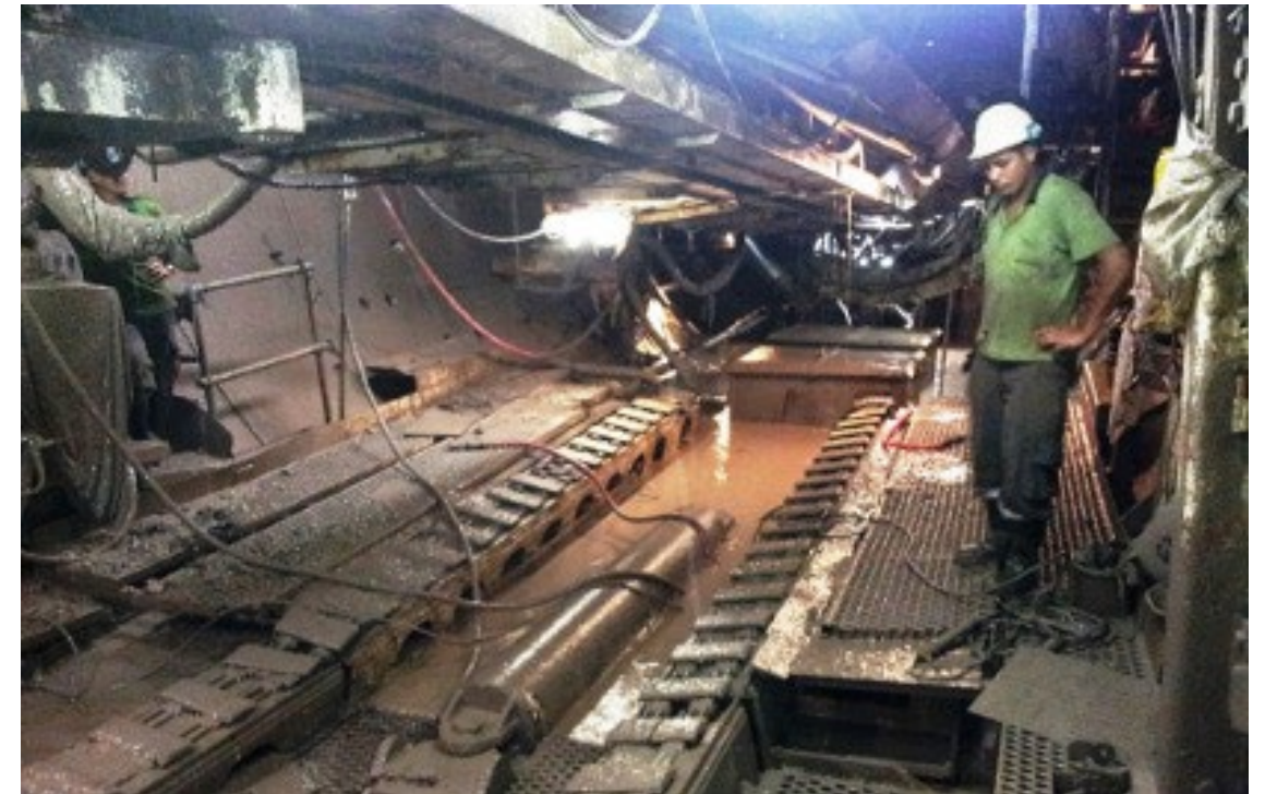
Fotografía 10. Interior de la máquina tuneladora durante la construcción
