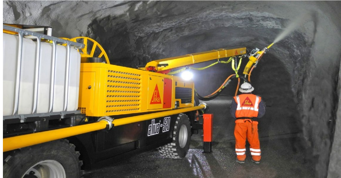
Fotografía 22. Aplicación a control remoto de concreto lanzado.
