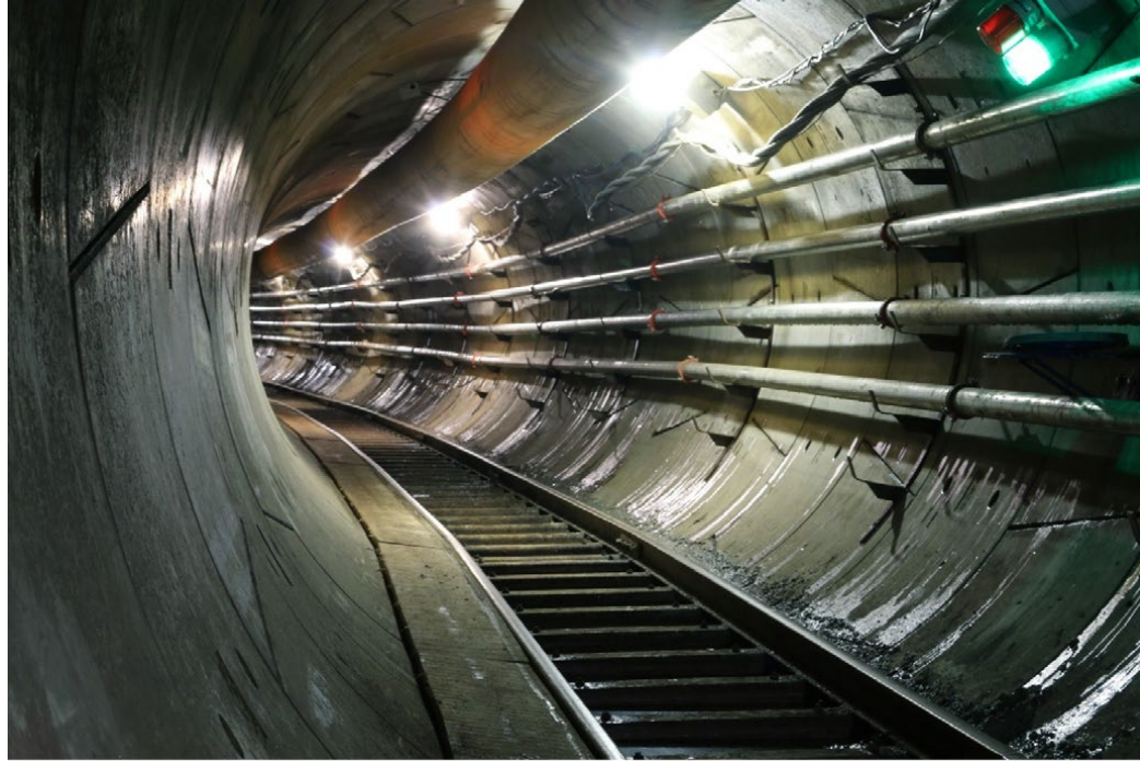
Fotografía 12. Interior del túnel de trasvase, área Metropolitana.
