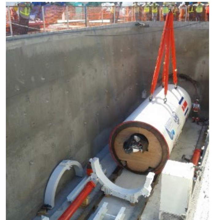
Fotografía 11. Descenso de la EPB en el pozo de lanzamiento para iniciar la excavación.
