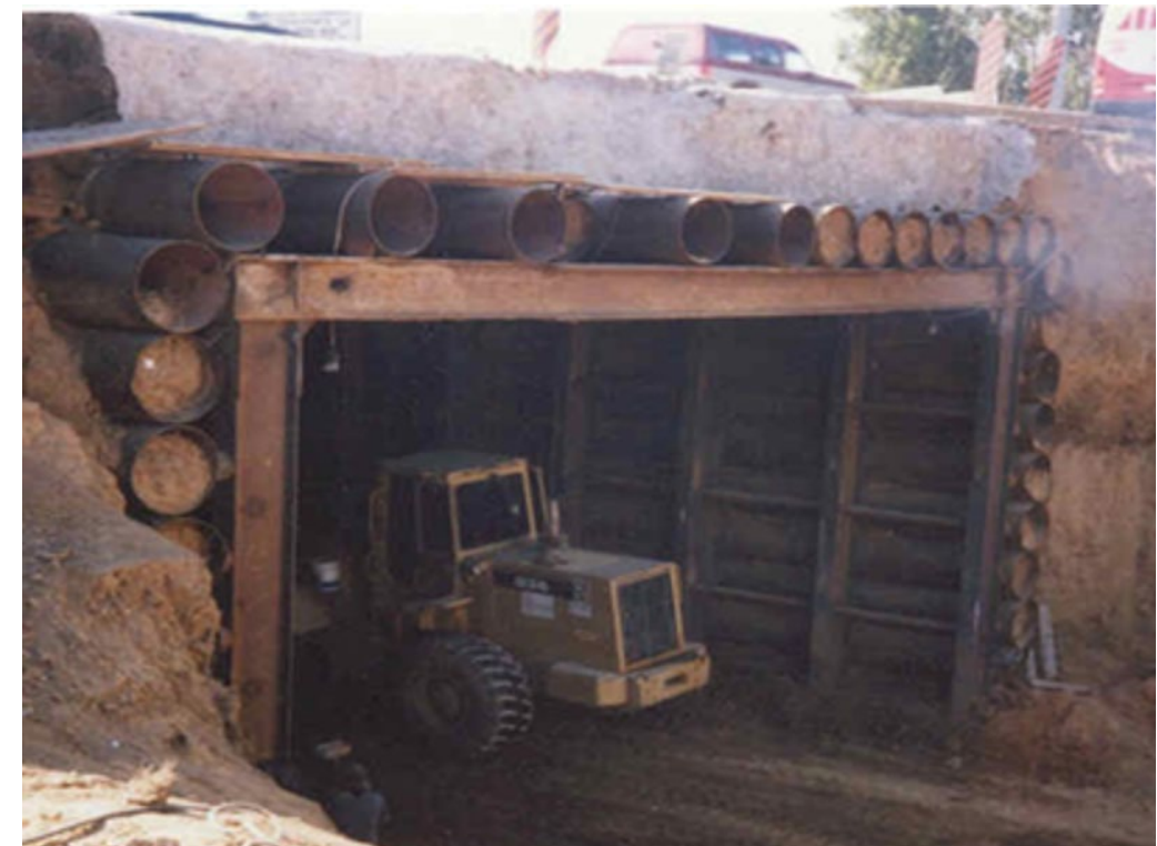
Fotografía 34. Proceso constructivo de un túnel con tubería hincada.
