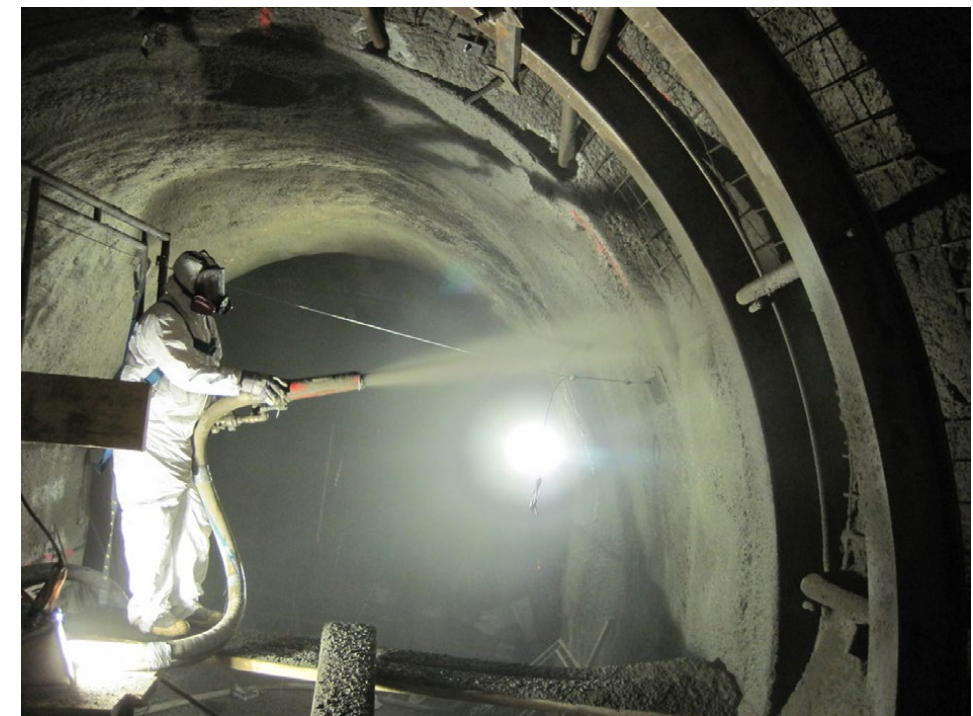
Fotografía 21. Aplicación manual de concreto lanzado.
