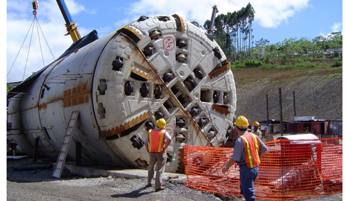
Fotografía 6. TBM de doble escudo usada en el túnel del PH La Joya.
