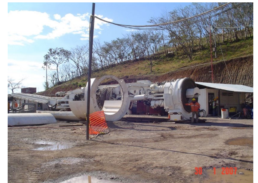
Fotografía 7. Ensamblaje de máquina tuneladora abierta, fuera del túnel, P.H. La Joya.
