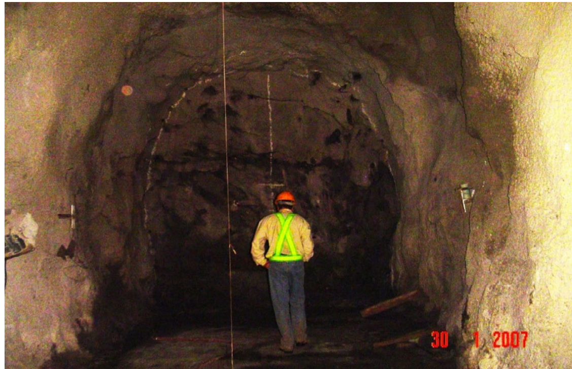
Fotografía 8. Condición del terreno al inicio de la excavación.
