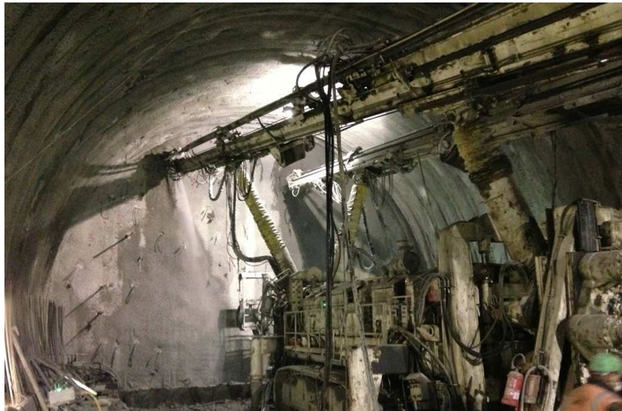
Fotografía 26. Instalación de pernos de fibra de vidrio en el frente de excavación.
