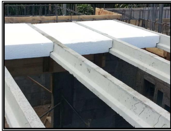
Imagen 18. Fotografía del montaje de un sistema de vigueta pretensado con bloque de poliestireno.
