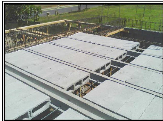
Imagen 19. Fotografía del montaje de un sistema de vigueta pretensado con bloques prefabricados.
