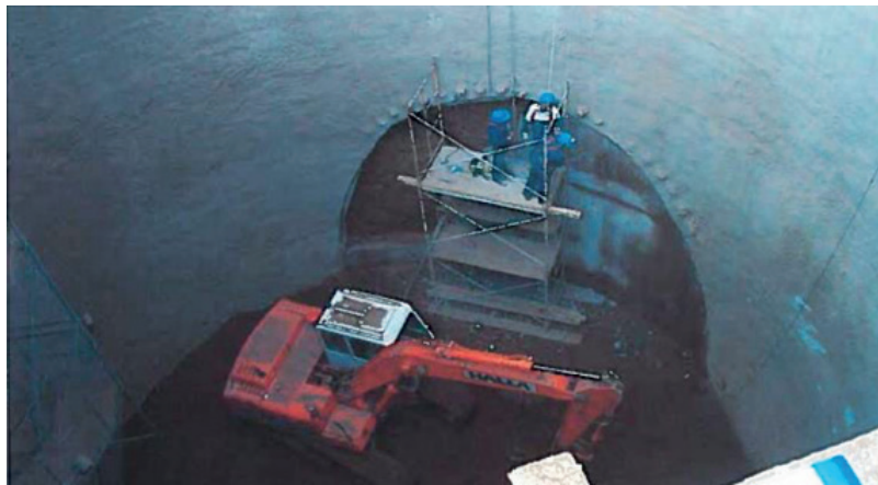
2. Galería de acceso
